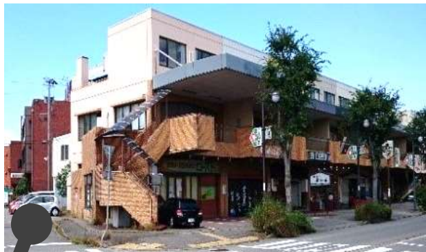
解体前の旧2丁目1番街ビル(手前)
